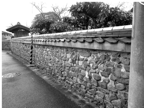
図1：和泉青石が使われている石垣(岬町淡輪)。
