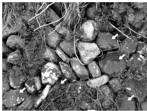
図3：一部にサヌカイト(矢印)が使われている石垣。太子町春日。
